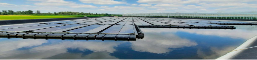
Figuur 9.3: Drijvende zonnepanelen op regenwaterbekken in Hoogstraten. 194
