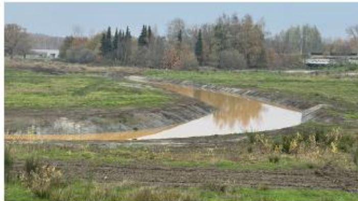
De nieuwe Netemeander aan de Hellekens. Links achteraan de nieuwe tunnel onder de spoorweg, rechts op de achtergrond de nieuwe Netebrug van de fietsroute Herentals-Balen. De koeienbrug moet nog worden aangelegd. FOTO MARC HILSEN
